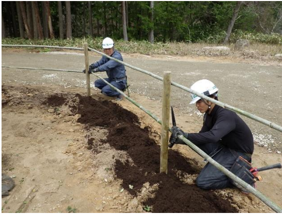
《生垣支柱設置工事》
