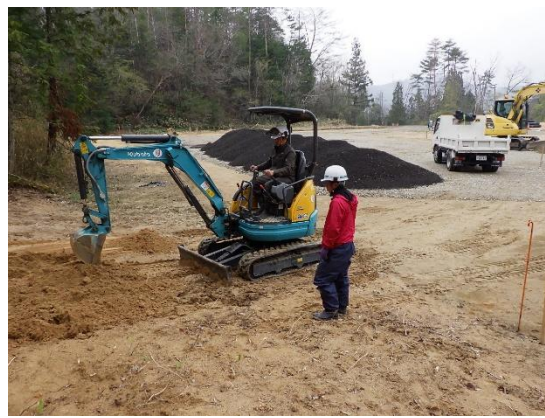
《重機操作訓練：小型車両系建設機械》
